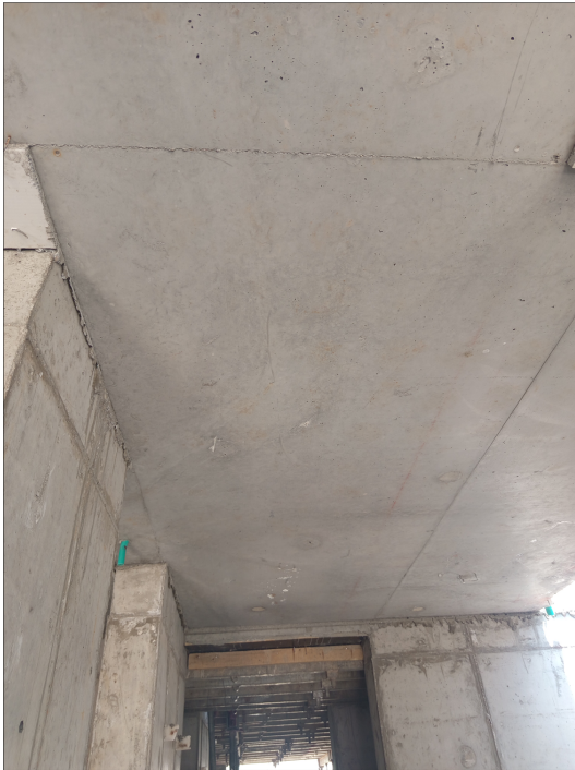
Acabados obra latitud 80
