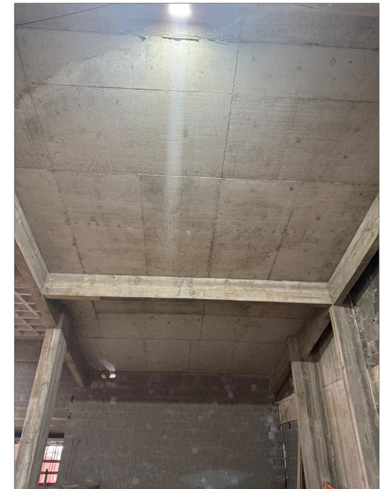
Acabados obra entrecielos
